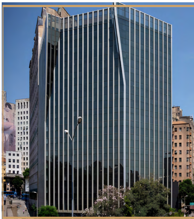
Foto 4: A nova sede da EJEJ: “Edifício Presidente Desembargador José Arthur de Carvalho Pereira”, na Avenida dos Andradas, nº 644, no Centro de Belo Horizonte.
